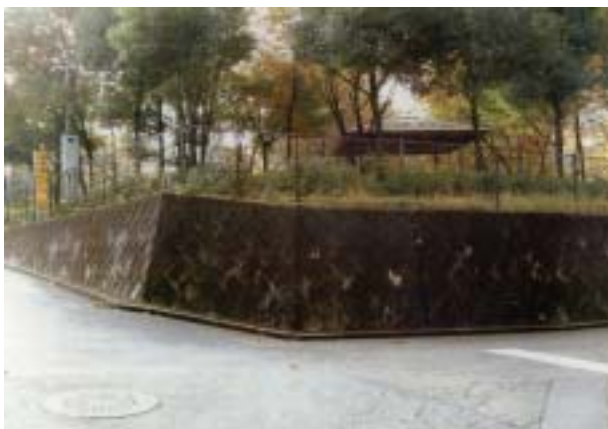
現在は擁壁となっている公園の北側
