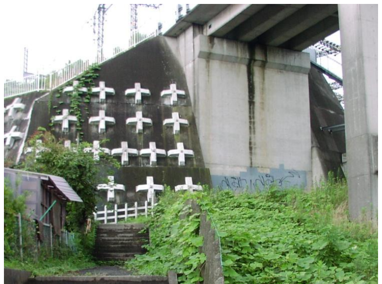
防災工事が施された斜面
